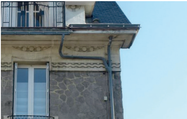
Réseaux d'eaux pluviales intégrés en façade, 42, rue Félibien
