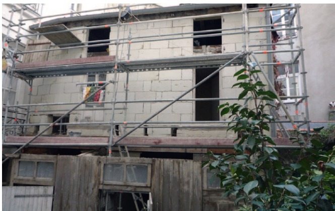
Travaux sur cour intérieure, © Elisabeth Pérot
