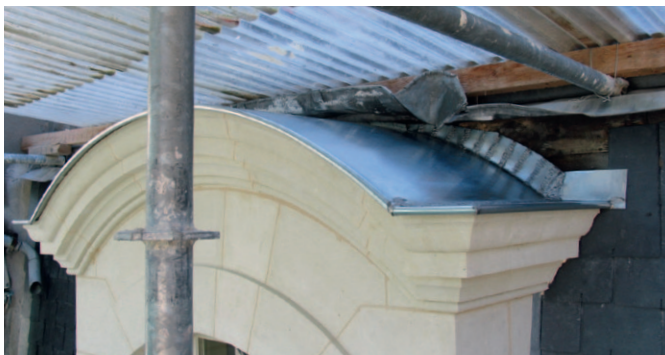
Remplacement de couvertines de protection en zinc
