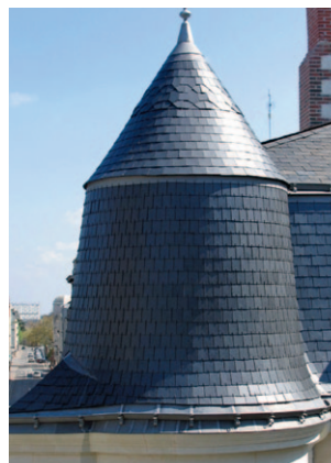
Couverture en ardoises, 5 et 17, rue de Verdun
