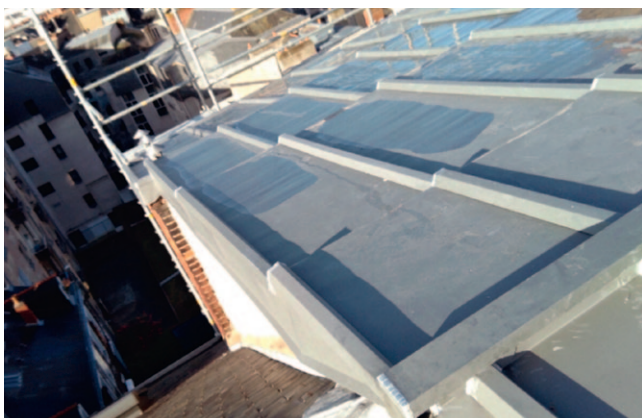
Couverture en zinc, © Blondy Couverture
