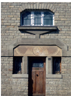
Linteaux et piliers béton
