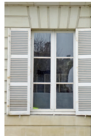
Contrevent extérieur, 19 rue du roi Albert
