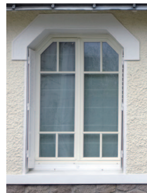
Menuiserie à petits bois, 11, place de la Chapelle
