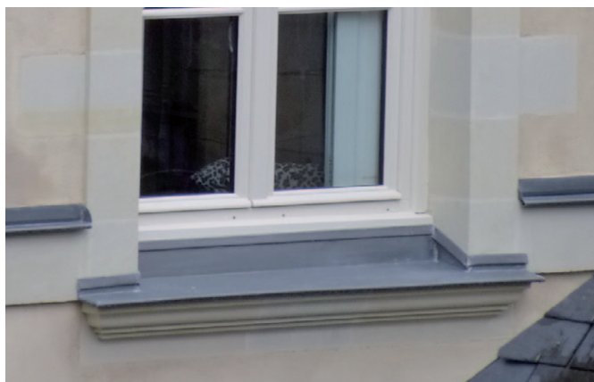
Feuille de zinc en protection d'un appui de fenêtre
