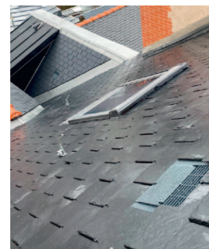
Exemple de fenêtres de toit sans saillie par rapport à la toiture, © Blondy Couverture
