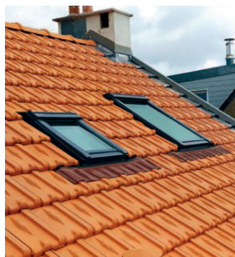
Exemple de fenêtres de toit sans saillie par rapport à la toiture, © Blondy Couverture
