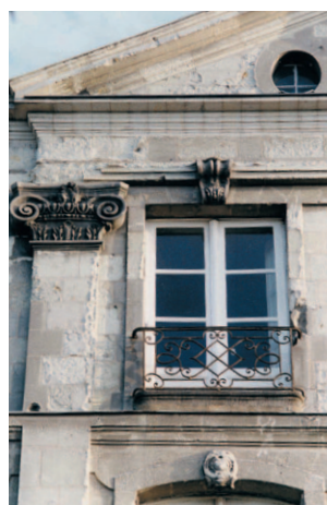
15, allée Duguay-Trouin avant restauration
