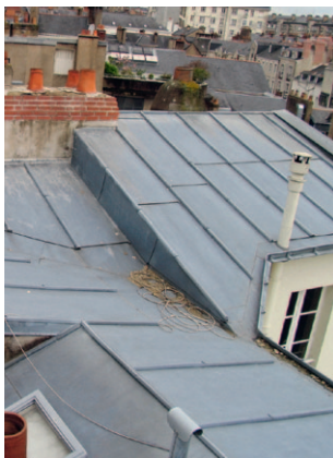
Toiture en zinc
