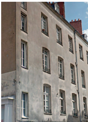
Mortier batard ancien, rue du Chapeau-Rouge, © Google, 2013
