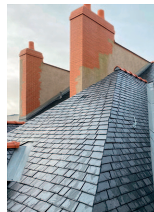
Différents conduits de cheminées en maçonnerie, briques industrielles et enduit ciment, © Blondy Couverture
