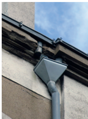
Boîte à eau et gouttière
