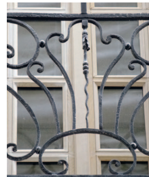
Ferronnerie XVIII e , 3, rue de Briord
