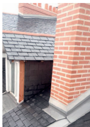
Différents conduits de cheminées en maçonnerie, briques industrielles et enduit ciment, © Blondy Couverture
