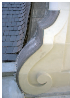
Exemple d'utilisation du plomb, 9 rue Kervégan
