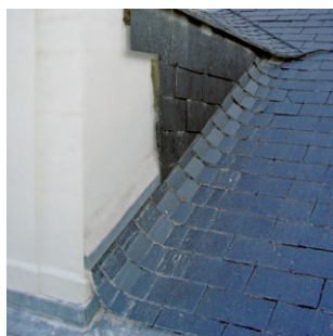
Noue ronde «renversée» en ardoises, 9, rue Kergévan
