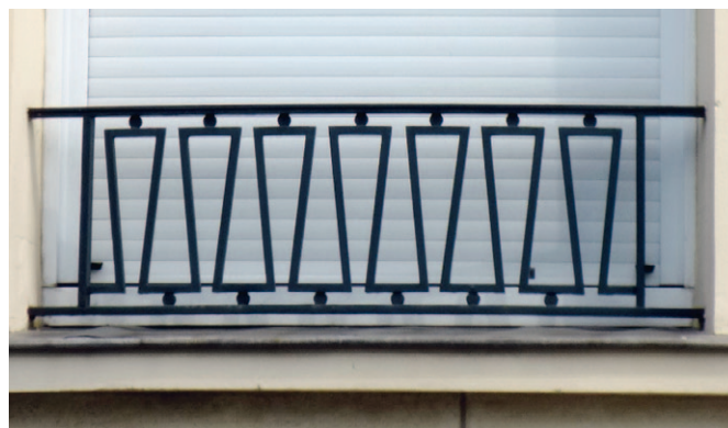
Ferronneries XX e , 33, rue Alexandre-Dumas
