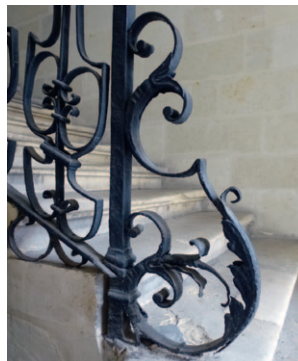
Ferronnerie XVII e , escalier du 13, rue de Briord
