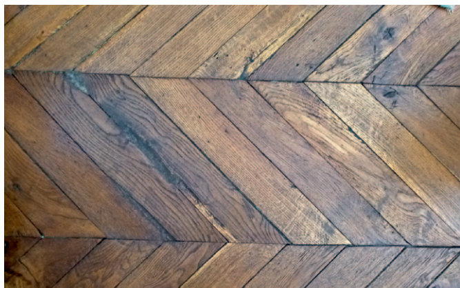
Pose en «Fougères» ou «point de Hongrie», quai de la Fosse
