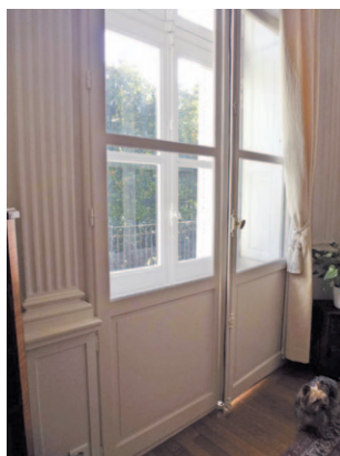
Double fenêtre, 3, rue Gresset
