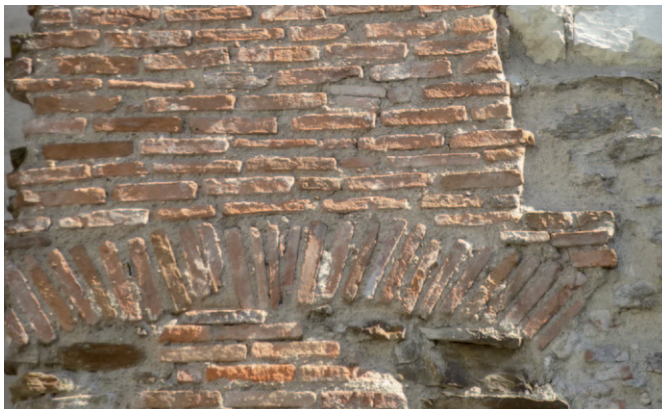
Conduit de cheminée en carreaux de terre cuite
