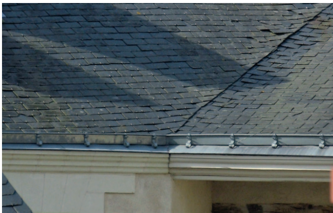
Gouttière dite « dalle nantaise »
