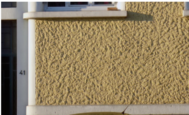
Enduit tyrolien peint, 41, rue Amiral-Courbet
