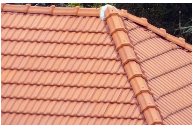
Tuiles mécaniques
