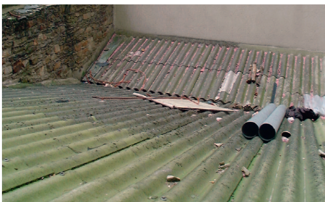
Tôles en fibrociment en arrière cour
