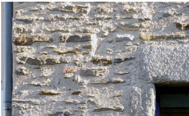
Moellons de micaschistes
