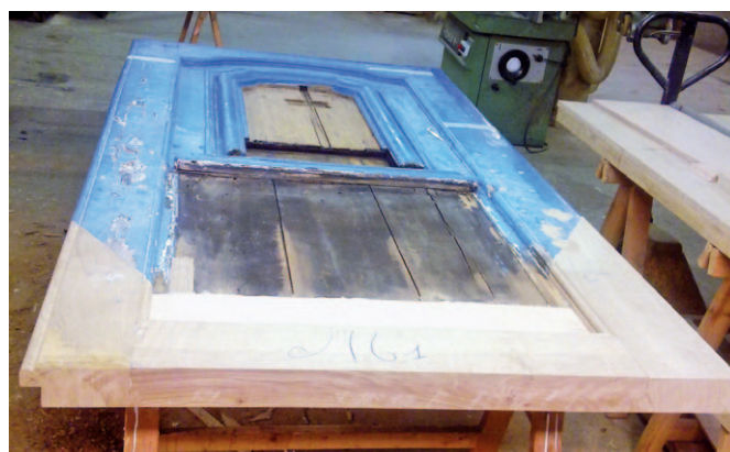
Bois neufs «entés» sur une porte ancienne, entreprise Gente-Poilane
