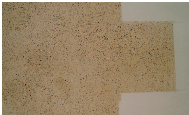
Enduit à la chaux rénové
