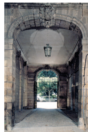
3, place de la Petite-Hollande avant restauration
