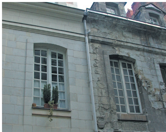
9, allée Turenne, immeubles mitoyens avant et après restauration
