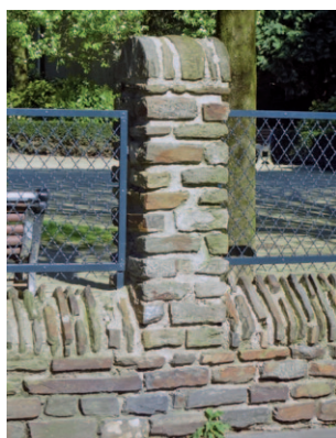
Muret d'espace public en moellons
