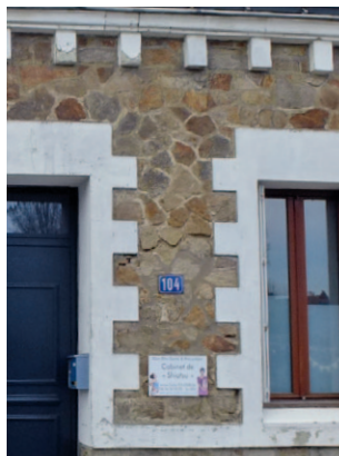
Maçonnerie micaschistes
