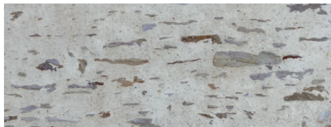
Enduit à «pierres vues»
