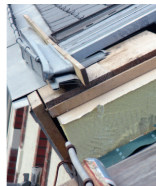
Isolation d'une toiture par l'extérieur, en «sarking»
