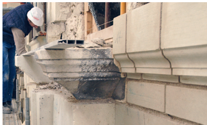
Réparation de corniches
