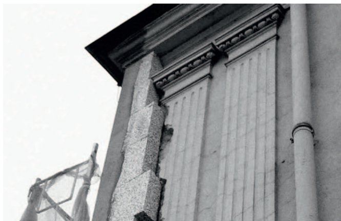
Isolation en façade et mauvais raccord avec existant (hors secteur nantais), © Pierre d'Angle – (ANABF Sept. 2020)
