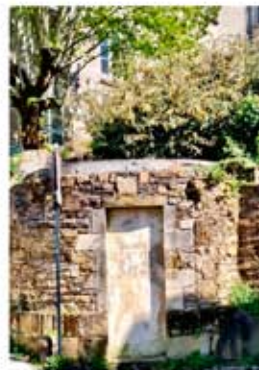
75, rue du Boccage
