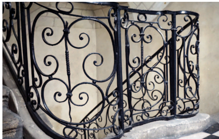
Rampe de l'escalier du palier, Temple du Goût à Nantes
