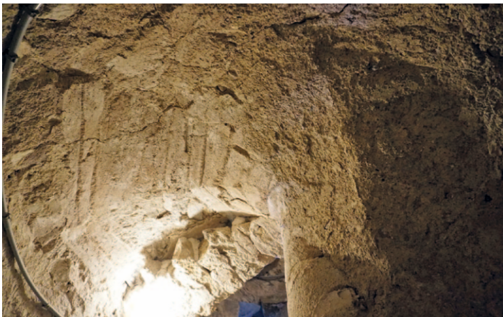
Escalier du clocher de l'Église Saint-Pierre, à Mortagne-sur-Sèvre
