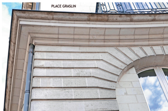
Place Graslin, façade en tuffeau, St Savinien, Lavoux et Granit
