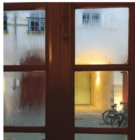
*Fenêtre avec des carreaux classiques et un carreau FINEO... le seul sans humidité*
