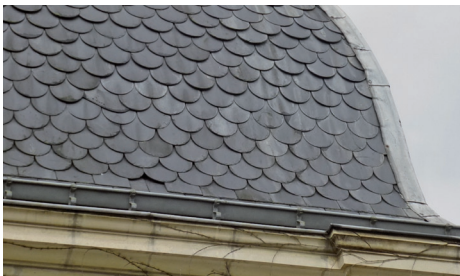
Ardoises en écaille pointées sur toiture de forme dite impériale
