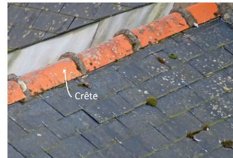
Faîteaux de terre cuite avec embarrure et crêtes de mortier
