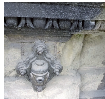
Pièce d'ancrage des câbles des premiers tramways encore présents sur certaines façades
