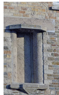
Micaschistes clivés et béton, 1924
