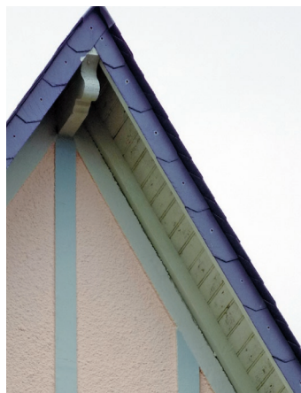
Rive en bardeli d'ardoise
