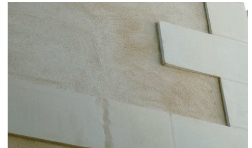
Enduit fin et encadrement de calcaire
