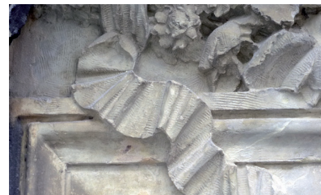
La technique du microgommage permet de conserver tout le détail et les traces d'instrument
