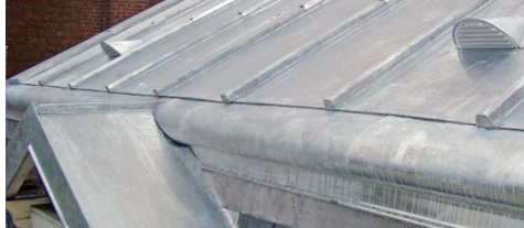
Bacs de zinc pose à tasseaux et couvre-joint
