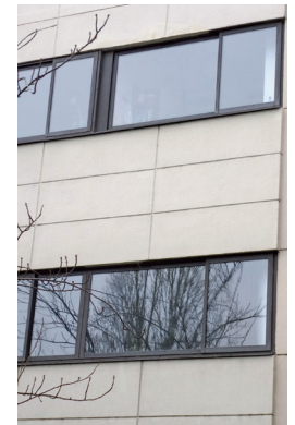
Fenêtre horizontale en acier mi-XX e
