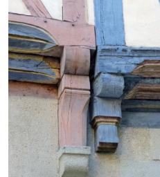
Les pans de bois extérieurs doivent être protégés ; ils sont souvent colorés
