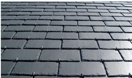
Ci-dessous : pose à crochets
