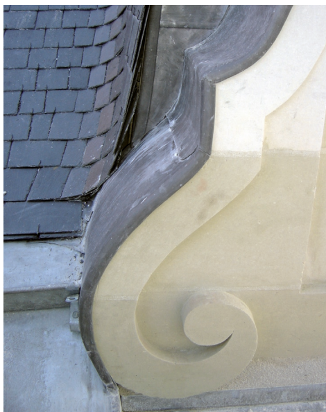
Protection d'une volute de lucarne en plomb
