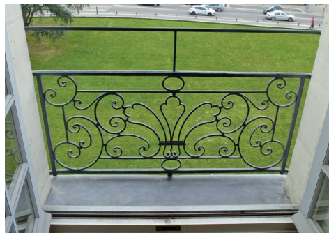
Mise au niveau réglementaire d'un garde-corps par une barre d'appui très fine
