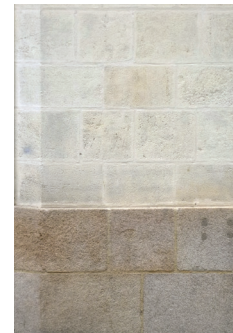
Assises de soubassement en granite
