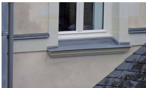
Protection des ressauts de façade en zinc
