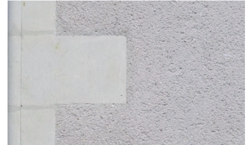
Enduit fin et encadrement de calcaire
