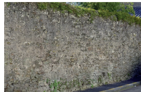
Mur de clôture
