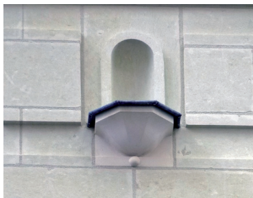
Toutes les parties horizontales doivent être protégées par du zinc
