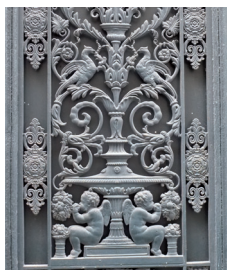
Ouvrage en fonte
