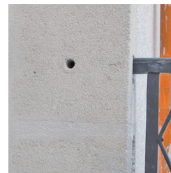
Trou de la broche d'ancrage
