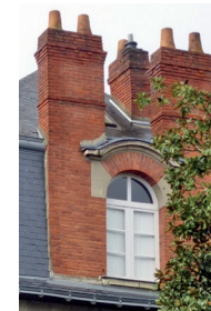
Souches composées avec une fenêtre de comble
