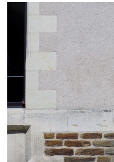
Encadrement de tuffeau, enduit et soubassement micaschiste
