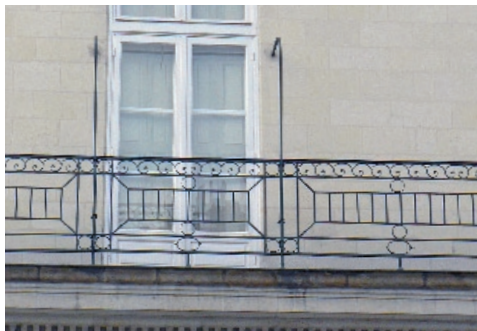
Arceau de fixation haute indispensable pour les garde-corps de grandes longueurs
