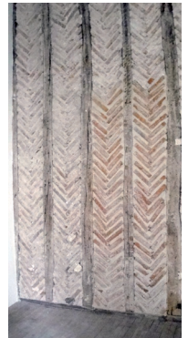
Ancien cloisonnement en pan de bois dont la structure peut mériter d'être révélee
