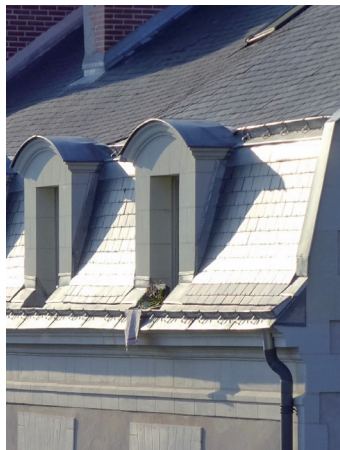
Bris Mansart XVII-XVIII e siècle avec deux niveaux de dalle nantaise
