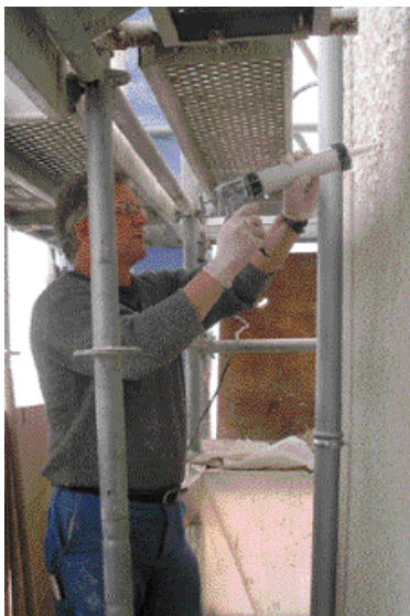
Enduits rapportés à la pompe à joint
