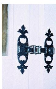
Restitution des menuiseries et ferrures XVII<sup>e</sup> à partir de celles encore en place
