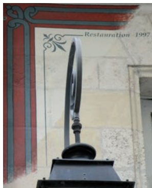
Détails de peinture d'une façade
