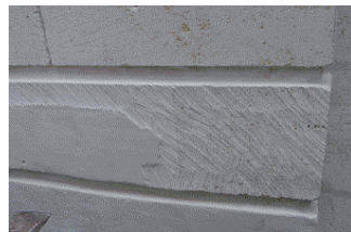
Détail d'une surface dressée (sireuil)
