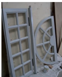
Démontage de la menuiserie
