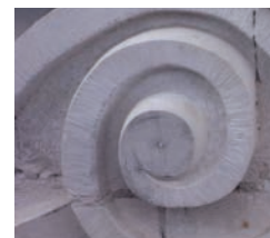
Détail des traces d'outil de gradine d'un massif sculpté
