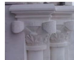
Remplacement à neuf de chapiteaux
