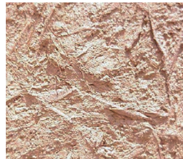
Exemple de torchis utilisé pour remplir les assemblages de pans de bois
