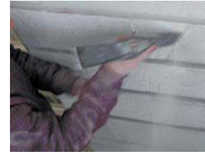
Tailleur de pierre dressant un parement tuffeau à l'aide d'une polka
