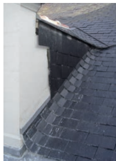
Réalisation d'une noue en ardoise
