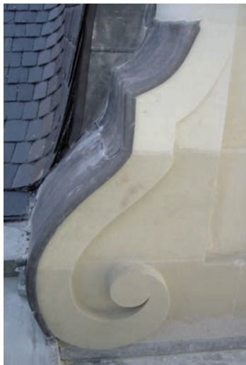
Protection en zinc d'un aileron de lucarne
