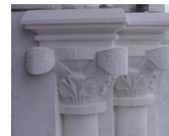
Remplacement à neuf de chapiteaux
