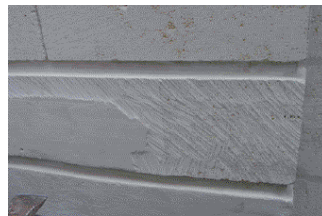
Détail d'une surface dressée (sireuil)
