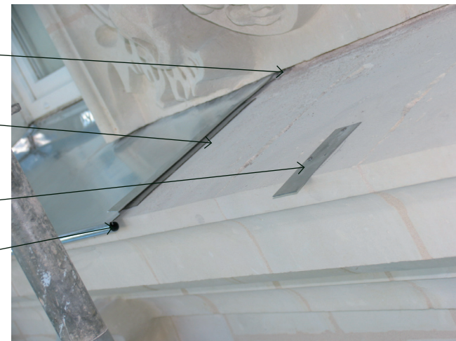
Pose d'un zinc sur un entablement
