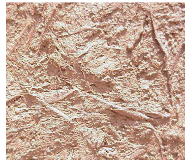
Exemple de torchis utilisé pour remplir les assemblages de pans de bois
