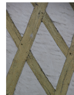
Peinture de pièce de charpente de pans de bois
