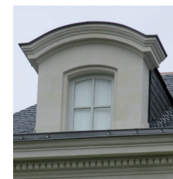
Exemple de conservation une lucarne d'origine
