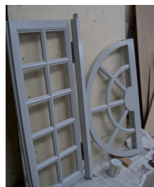
Démontage de la menuiserie
