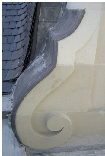
Protection en zinc d'un aileron de lucarne
