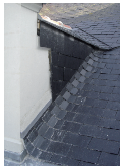
Réalisation d'une noue en ardoise
