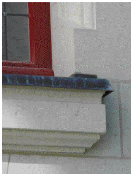
Protection d'appui fenètre en plomb
