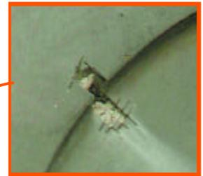
Sondage faisant apparaître le tuffeau sous le ciment
