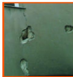
Sondage montrant les fissurations de l'enduit
