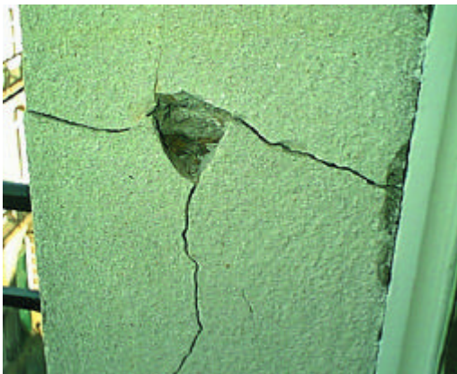
Vue en tableau d'une fenêtre
