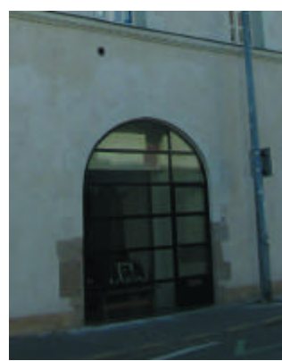
Ancien portail des écuries
