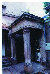
Plate-bande appareillée maintenue par une armature interne
