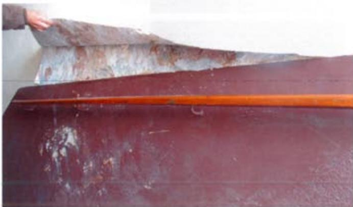
ill.2 Dégradation insidieuse d'une paroi en simple épaisseur de tuffeau derrière une toile de verre dans une cage d'escalier
