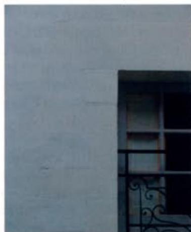
Badigeon masquant à la fois l'appareil de tuffeau et l'enduit à la chaux
